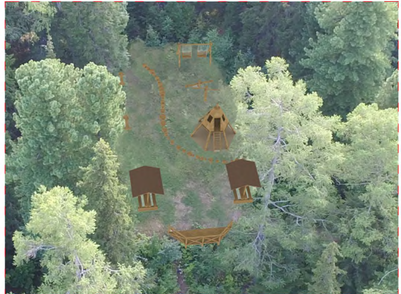
Фото после проведения работ
