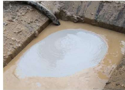
Фото устройства «стены в грунте». ОПР 2019 год
