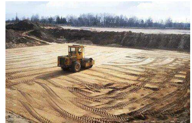
Устройство ПФЭ с применением БЕНТОМИКС®
